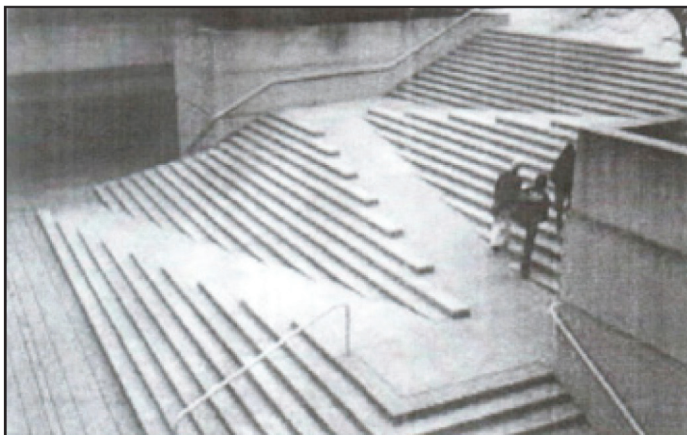
الشكل (8-2): ب- طريقة لدمج المنحدرات مع الادرار
